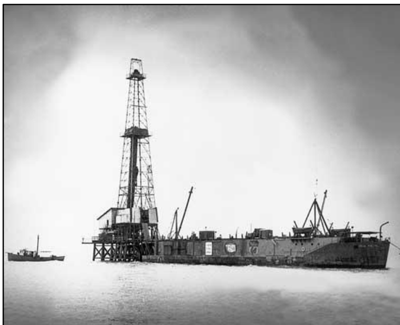
Figura 8 . A plataforma de perfuração Kermac 16 foi a primeira unidade fixa offshore construída no Golfo do México, nos EUA, em 1947, posicionada a 14,5 quilômetros da costa (OFFSHORE, 2004).
