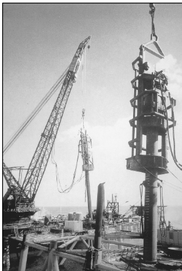
Figura 14 . Cravação das estacas de uma jaqueta com o auxílio de martelos hidráulicos (GERWICK JR., 1999).
